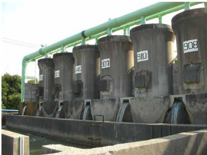
**写真3:**天然ガスとかん水を分離するセパレーターとかん水を集める沈砂槽。
