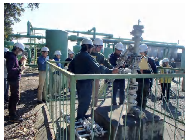
写真 4 生産井戸のパイプに手を置いて、かん水の揚がってくる様子を実感
