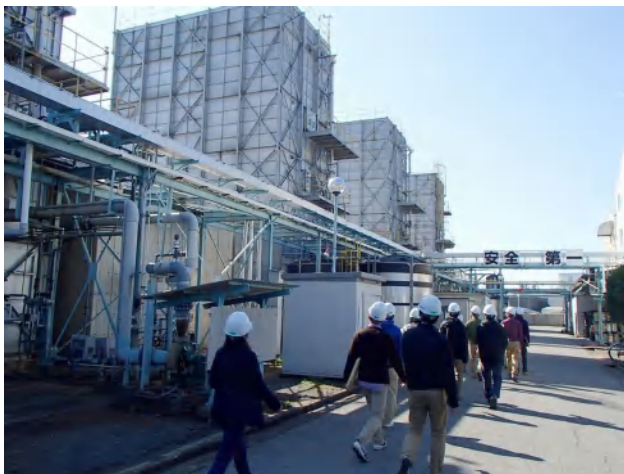
写真 3 ヨウ素生産過程で最も大がかりな施設の放散塔と吸収塔が一体となった塔が並ぶ構内
