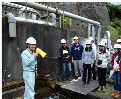
写真 7 天然ガスとかん水を分離する能実基地のセパレーター。説明しているのは、池田賢治鉱業部長。
