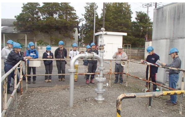
写真 29 かん水の一部を地下にもどす還元井についての説明
